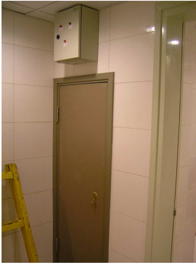
地下污水泵水位警報器控制箱(已改位)
